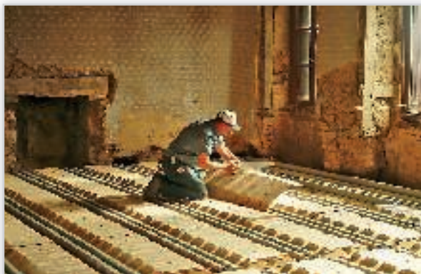
RECTOR, Systemy stropowe RECTOBETON i RECTOLIGHT. Stosowane przy renowacjach. Wymiana stropu charakteryzuje się: łatwością i szybkością montażu, lekkością konstrukcji stropowej – ciężar od 187 kg/m 2 , możliwy montaż bezpodporowy – nawet do 5,8 m, możliwość wykonania wieńca na pierwszym rzędzie pustaków, oparcie belek w gniazdach w ścianach.
