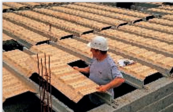
RECTOR, Strop nad przestrznią wentylowaną. Alternatywne rozwiązanie dla tradycyjnych podłóg na gruncie. Zalety: wentylacja przestrzeni podpodłogowych, eliminacja możliwości popełnienia błędów wykonawczych, zastosowanie zamiast tradycyjnej posadzki na terenach gruntów spoistych to rozwiązanie łatwiejsze w wykonaniu i bardziej ekonomiczne.
